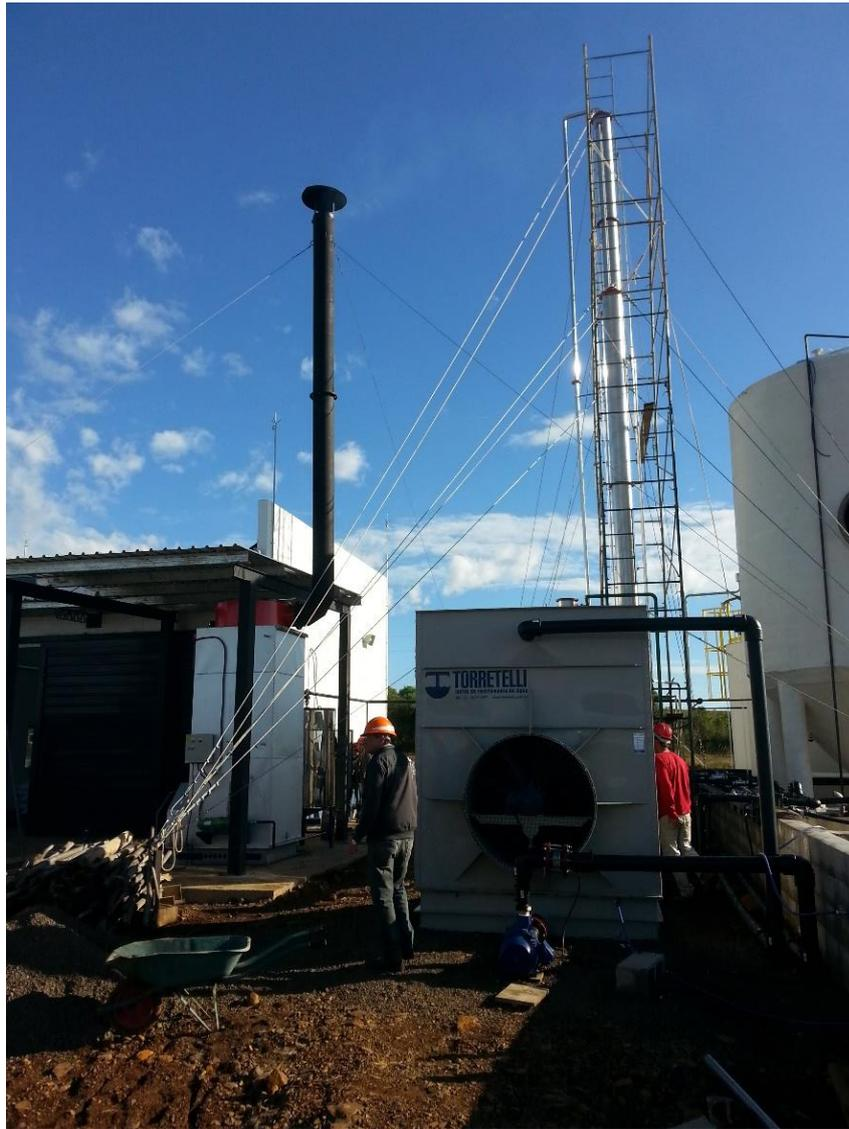
*Torre de enfriamiento, detrás se aprecia el módulo de destilación-rectificación*
